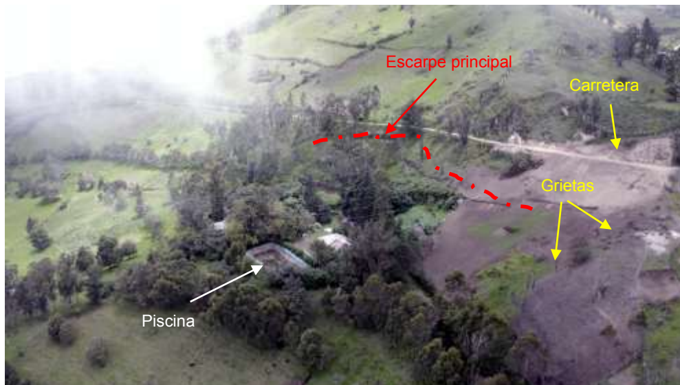
Figura 10. Vista panorámica de la carretera en el sector de Cullpa. (IIGE, febrero 2021)
