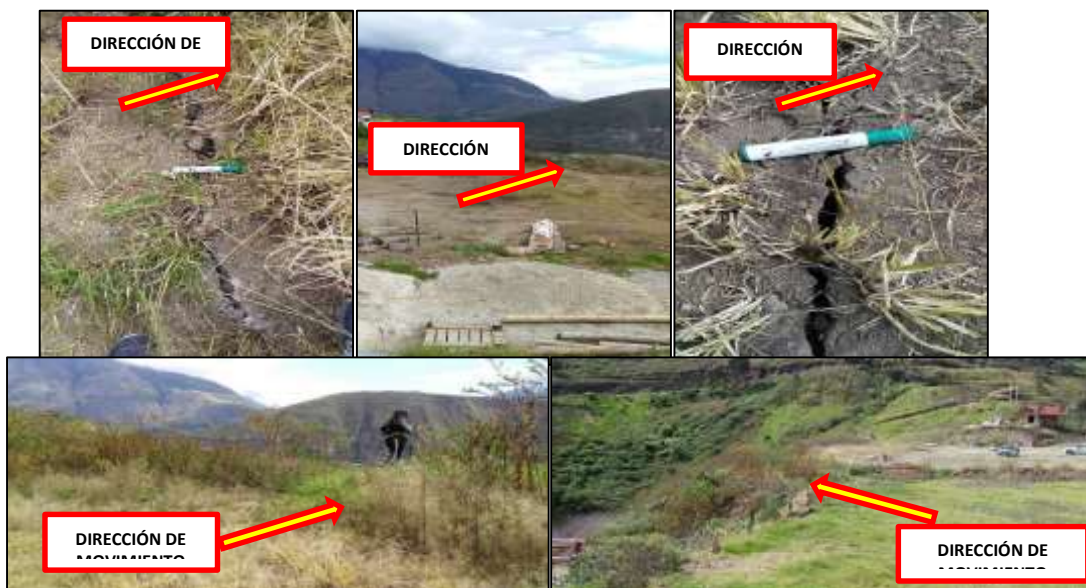
Fotografía 2. Imágenes de grietas G2 en el sector La Gallera.
